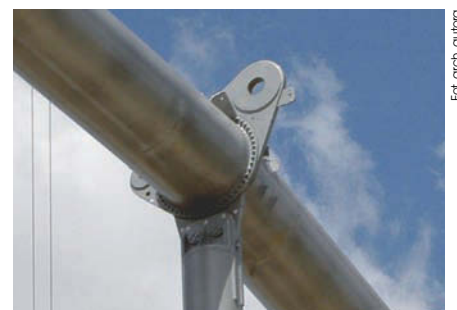
Rys. 8. Szczegół połączenia segmentów pierścienia ze słupem
