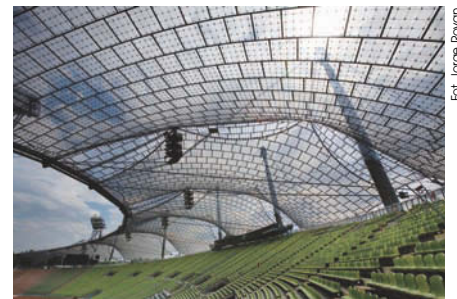
Rys. 4 Przekrycie namiotowe stadionu w Monachium
