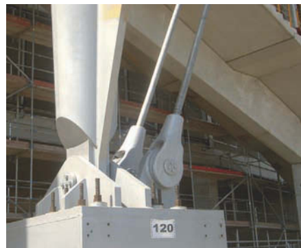
Rys. 9. Szczegół oparcia słupa na stopie fundamentowej
