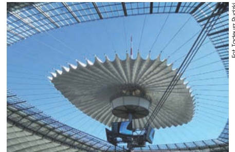
Rys. 5. Przekrycie Stadionu Narodowego
