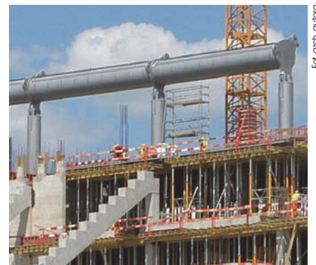
Rys. 7. Montaż pierścienia brzegowego
