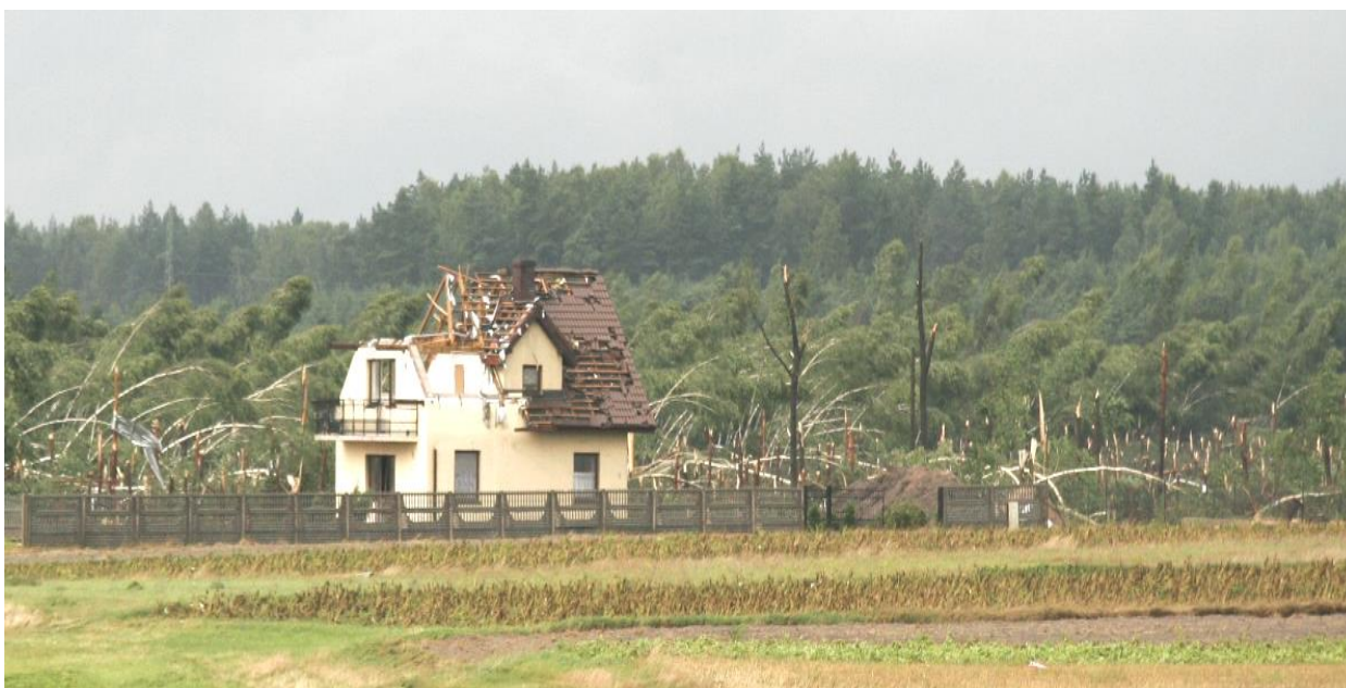
Rys. 40. Widok zniszczeń po przejściu trąby powietrznej 15.08.2008 r. w Kalinie
