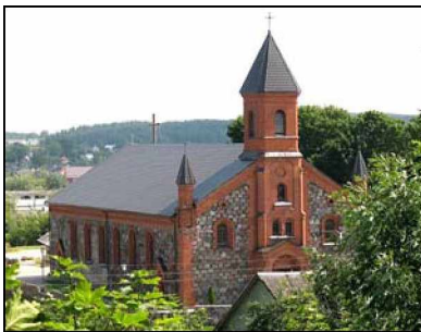
Fot. 47. Kościół w Brasławiu – widok z Góry Zamkowej (fot. T. Szczypek)
