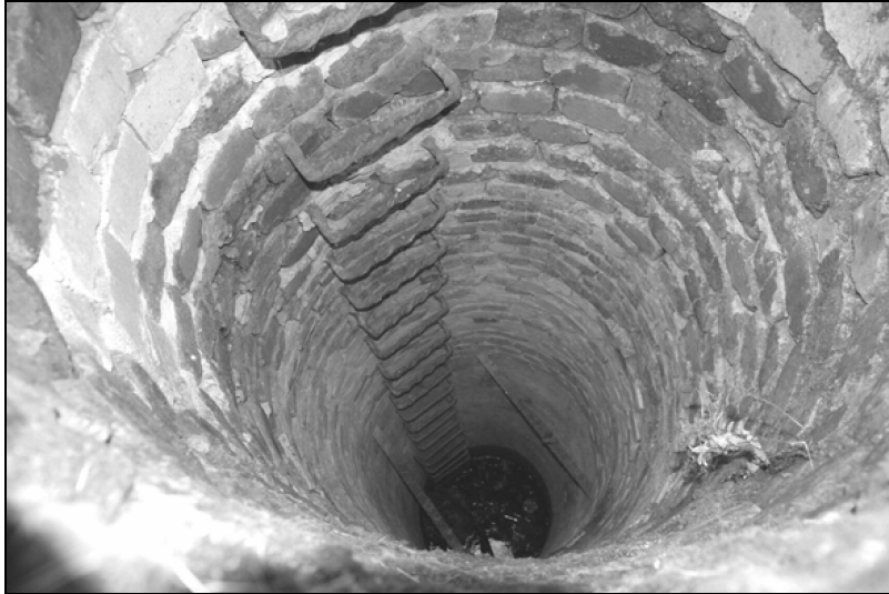
Rys. 6. Dawny szyb wentylacyjny poziomu sztolni odwadniającej. Fot. M.Furmankiewicz.
